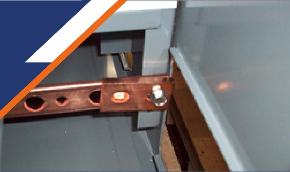
Instalación de kit de acoplamiento
